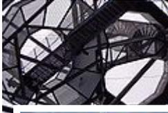
Der Tetraeder ist eine etwa 50 m hohe Stahl- Konstruktion in Form eines Kohlestoffatoms, die auf vier 8 m hohen Betonpfeilern ruht. Er befindet sich auf der Kuppe der etwa 80 m hohen Halde.
